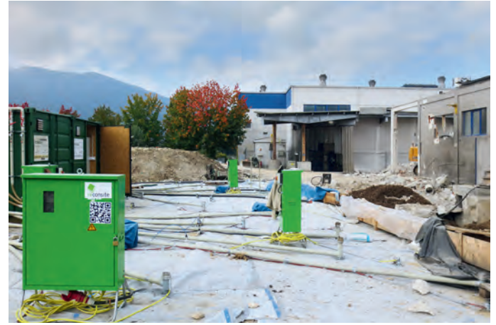
Abb. 6: Sanierungsbereich Objekt 10 vor Beginn des Hallenneubaus. Die Oberflächenabdeckung verhindert das Versickern von Regenwasser (Foto: reconsite GmbH)
