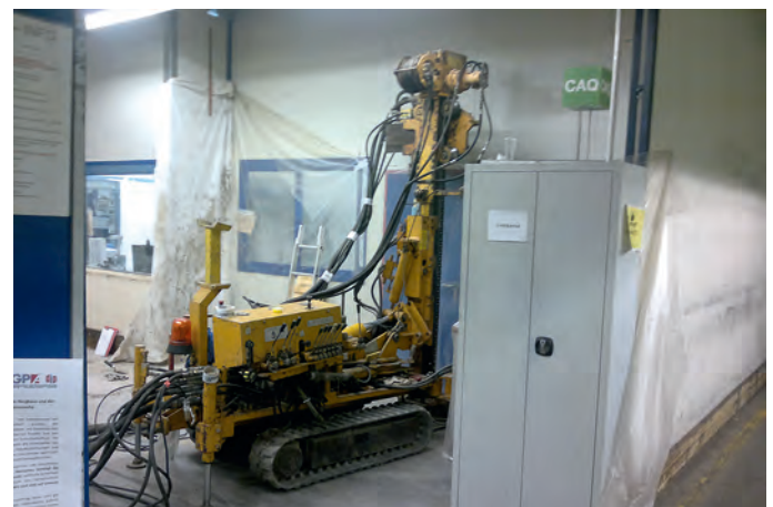
Abb. 4: Bohrarbeiten im Gebäude in der Nähe des laufenden Produktionsbetriebs (Foto: reconsite GmbH)
