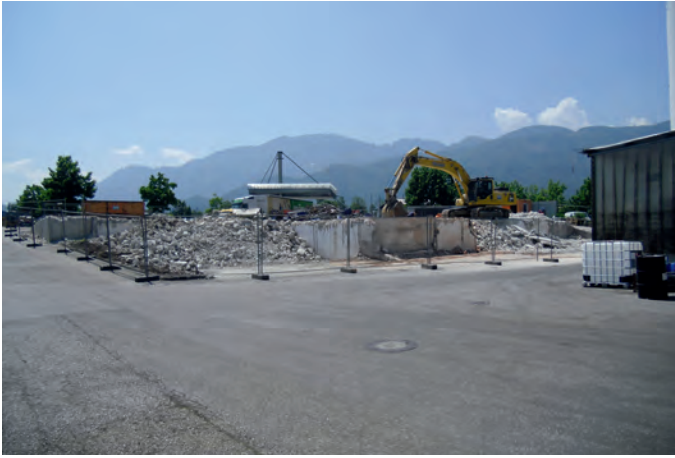
Abb. 5: Gebäudeabbruch bei Objekt 10 (Foto: reconsite GmbH)
