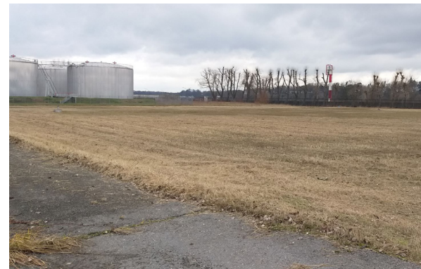
Vorbereitung der Brachfläche für die Sanierungsarbeiten (Januar 2019)
